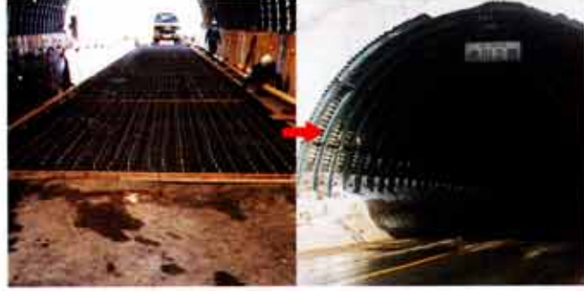
太陽熱蓄熱融雪(米子自動車道 蒜山サービスエリア)
