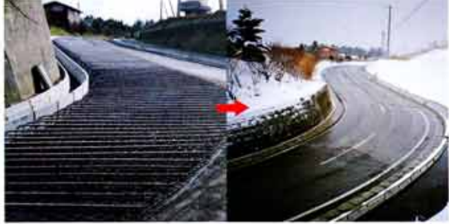
地下水熱源・温泉水熱源(国道115号線土湯トンネル)
