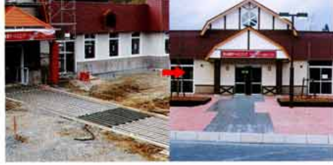
太陽熱蓄熱融雪(米子自動車道 蒜山サービスエリア)
