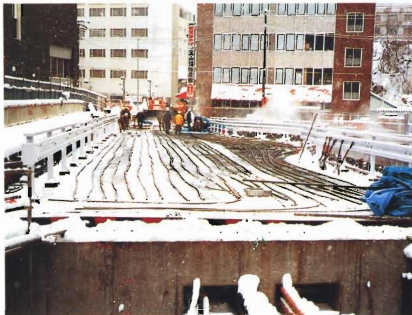
ヒートパイプ布設状況
