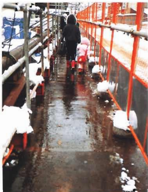
ロードヒーティングシステムを採用した道路の融雪状況
