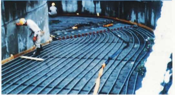
長尺コルゲート型ヒートパイプの布設例
