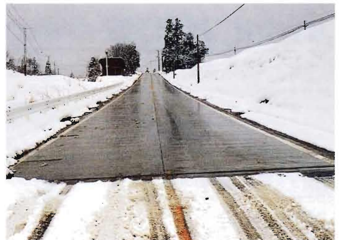
車道融雪例(ボイラー熱源型)
