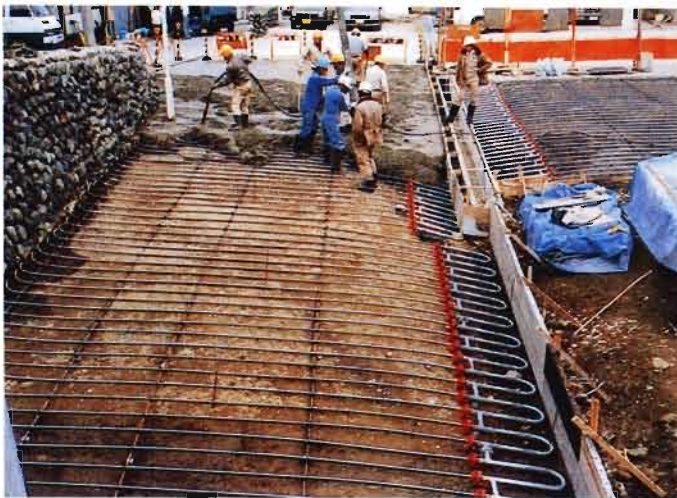
駐車場でのヒートパイプ施工状況(ボイラー熱源型)
