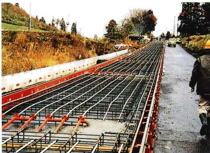
車道でのヒートパイプ施工状況(ボイラー熱源型)
