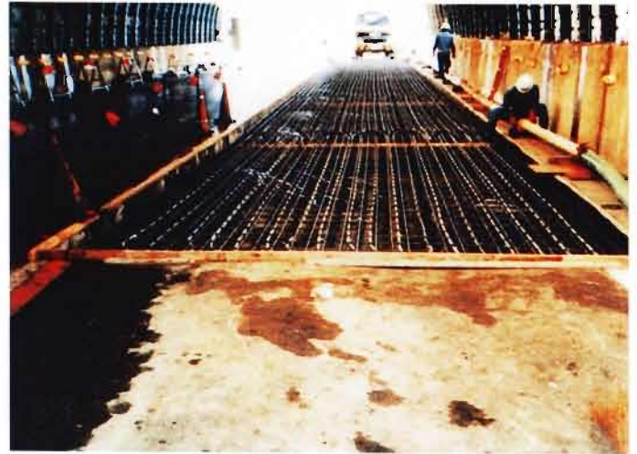
地熱利用型ヒートパイプ式凍結防止工事
