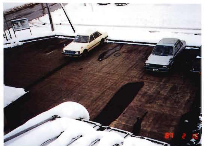
駐車場融雪例(ボイラー熱源型)
