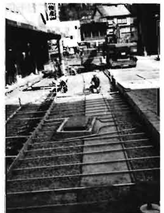
図40 定山溪温泉融雪システム Jozankei Spa heat pipe type snow melting and deicing system
