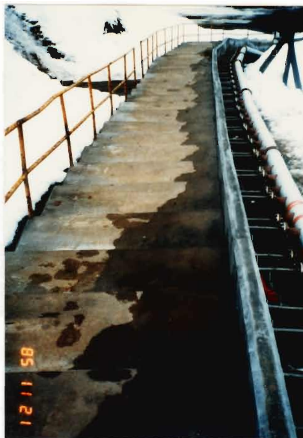
鉱内廃湯利用による階段部の融雪状況 (札幌 豊羽鉱山殿)
