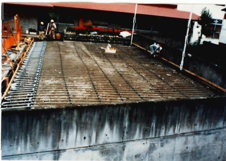
布設状況 (越後湯沢ホテルニューオータニ殿)
