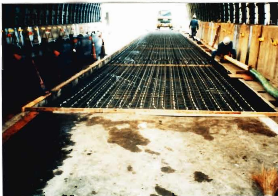
布設状況（長野県国道18号線）
