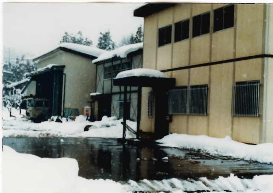
融雪状況（長岡市榑中元道路殿）
