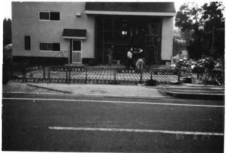
図-7 駐車場でのヒートパイプ施工
