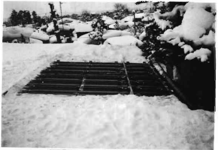
図-10 横手市のヒートパイプ式融雪屋根
