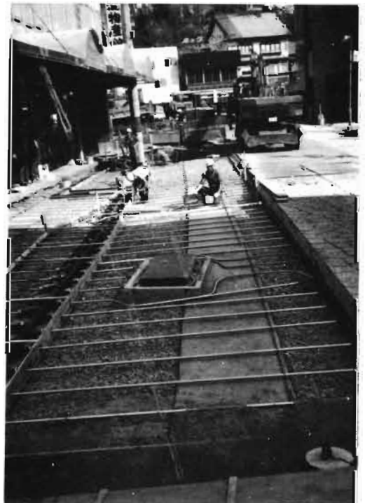
図-5 ヒートパイプの布設状況
